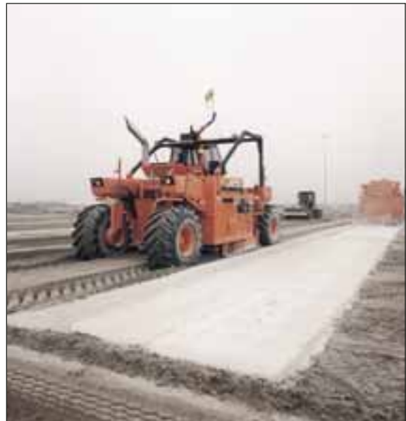
Figuur 21 Stabilisatie met cement
