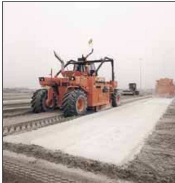
Figuur 21 Stabilisatie met cement
